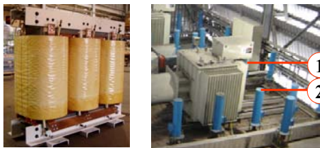
Slika 36. Transformatorsko-ispravljački sistem levo- Transformator bez kućišta desno- 1. TI sistem, 2. Otresaći elektroda
