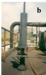
Slika 38. Otresaći u elektrostatičkim filterima a) Mehanički, b) Magnetno-gravitacioni, c) Elektromagnetni
